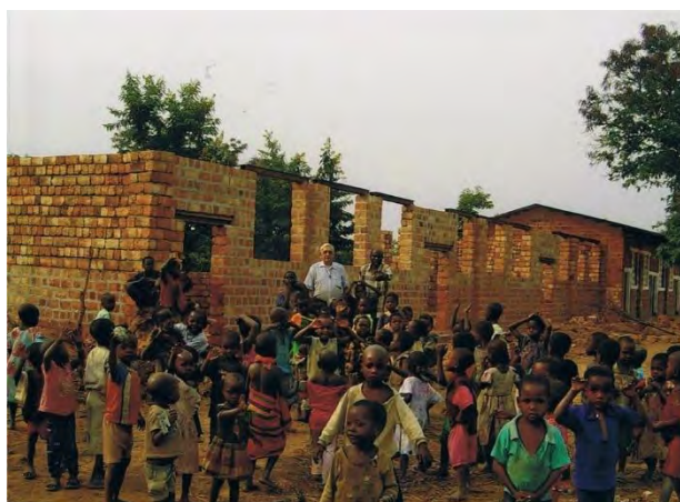
Wśród dzieci przed budowaną szkołą w Kankindu, 2009 r.
