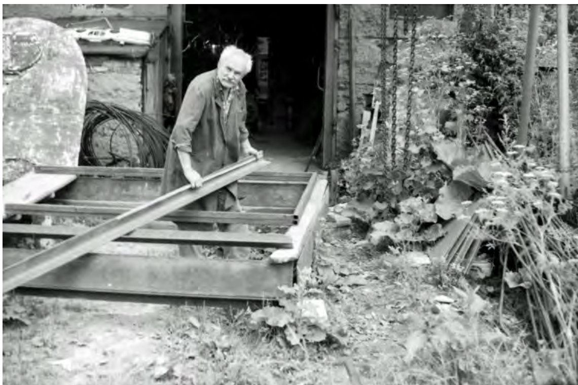
Julian Boss-Gostłowski podczas budowy pomnika
